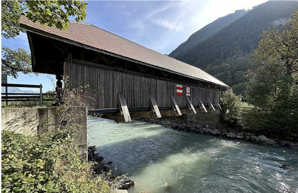
Lütschine km 2.510: Signalisation Aenderbergbrücke
